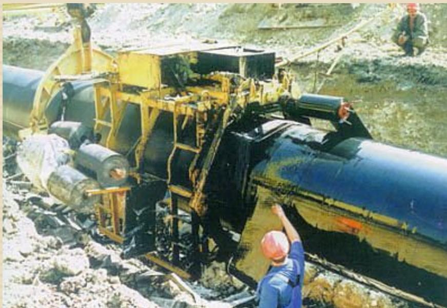
Битумная мастика может наноситься в один или два слоя. В последнем случае между слоями мастики для увеличения механической прочности покрытия наносят слой армирующей обертки из стеклохолста. Для защиты слоя битумной мастики от механических повреждений она покрывается сверху защитной оберткой.
