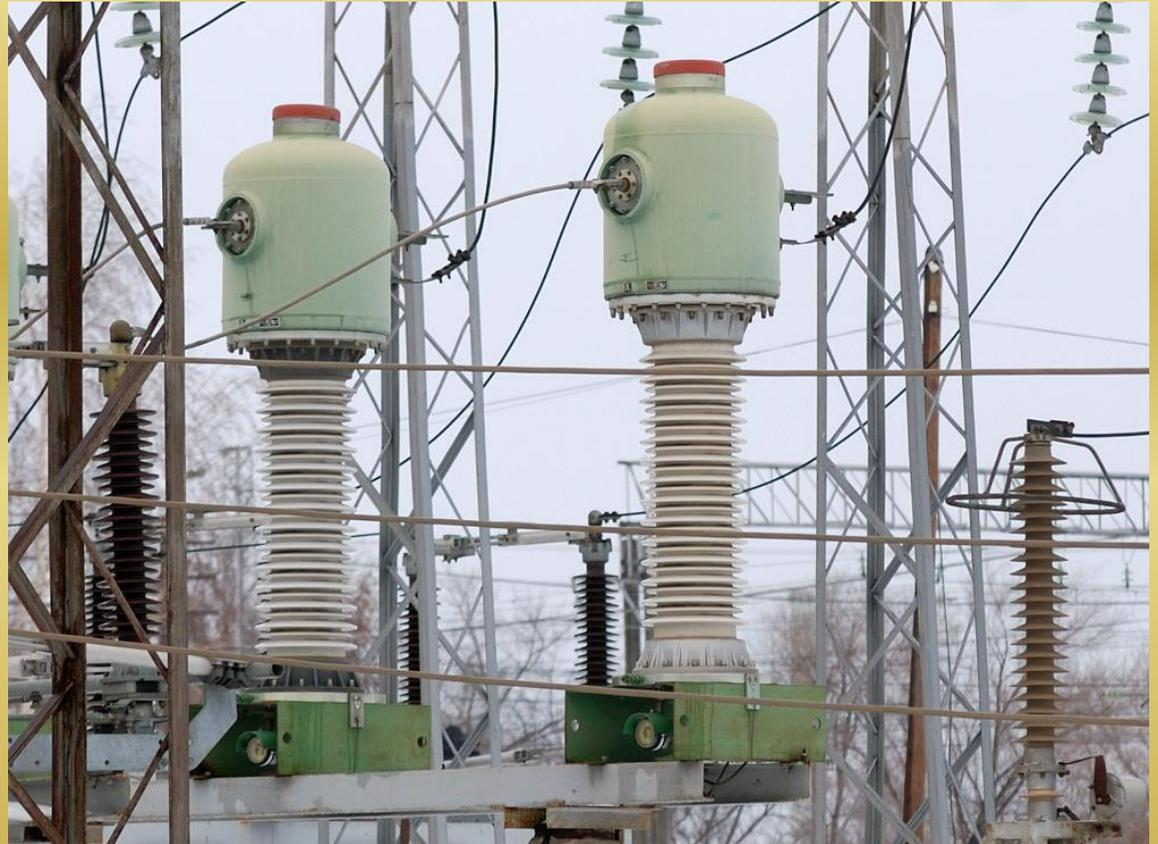
**ИЗМЕРИТЕЛЬНЫЙ ТРАНСФОРМАТОР ТОКА С ЭЛЕГАЗОВОЙ ИЗОЛЯЦИЕЙ ТОГ-110**
