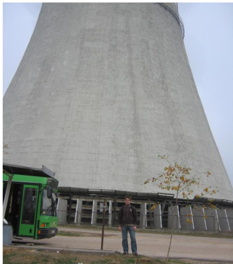
Техническая вода, использованная для конденсации пара на выходе из паровой турбины, охлаждается в градирне, стекая по внутренним стенкам башни, за счет испарения при контакте с восходящим потоком воздуха.
