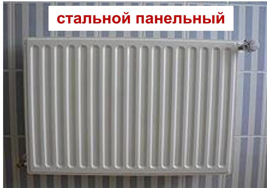
**Внутри:** *вынужденно-конвективная теплоотдача* от горячей воды к стенке радиатора
