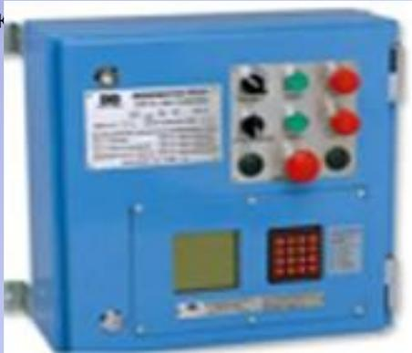
Цель MineWATCH общего блока управления предназначен для различных приложений, в том числе управление насосами, управление вентилятором и авто-контур управления.
