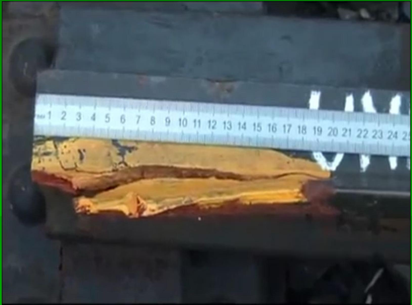
**Понижение острия против рамного рельса и подвижного сердечника против усовика на 2 мм и более, измеряемое в сечении, где ширина головки острия или подвижного сердечника поверху 50 мм и более.**
