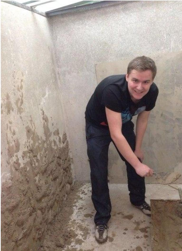
На практике в 1 СП (м. Люблино), мы учились подготавливать раствор для шпаклевки, для этого мы брали сухой смесью и разбавляли ее водой. Затем мы обрабатывали поверхность грунтовкой, а после этого наносили шпаклевку на стену. Так же учились класть плитку на шпаклевку, на пол и на стену, при помощи уровня.
