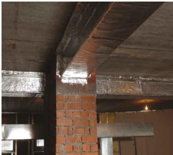
Обтяжка теплоизоляционным негорящим
