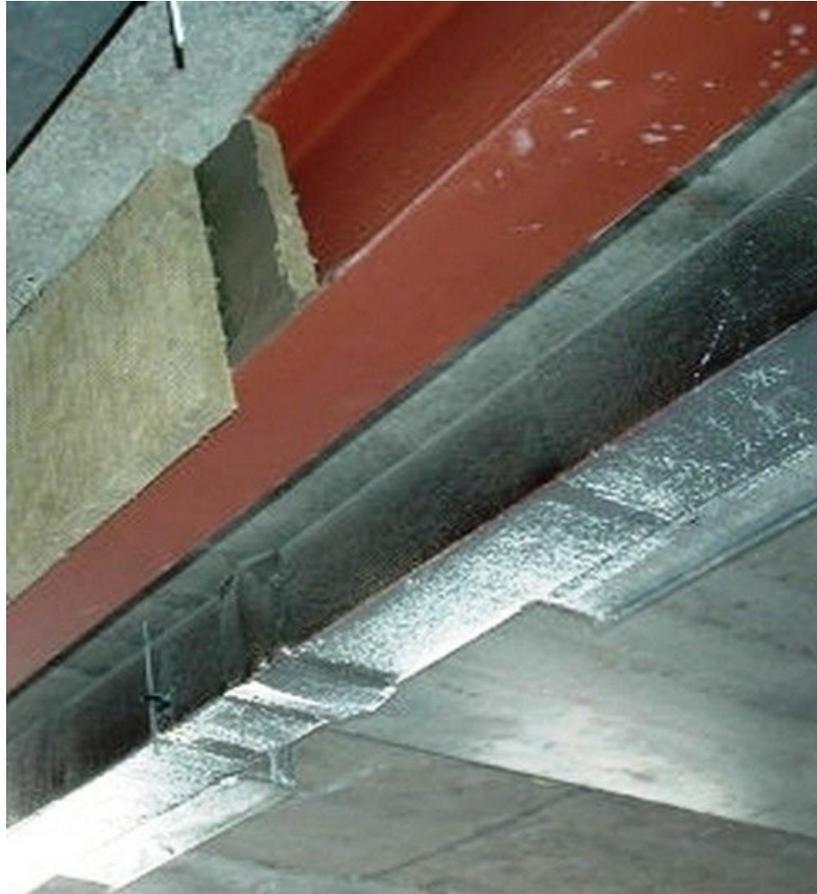
**Легкие огнезащитные облицовки** из листовых или плитных материалов (гипсокартонных листов, полужестких минеральных плит (МВП), перлито-фосфогелевых плит и др.) укрепляются с помощью стальных анкеров и каркаса. Например минераловатная плита толщиной 5 см обеспечивает предел огнестойкости конструкции 2 часа, однако нуждается в дополнительной декоративной облицовке, а каждый слой гипсокартона толщиной 12-14 мм повышает
