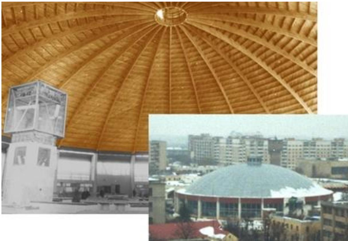
Купол диаметром 60 метров и стрелой подъема 12 метров выполнен по ребристо-кольцевой схеме. Основными несущими элементами являются деревянные клееные радиальные ребра, сечением 160 x 800 мм, замкнутые верхним деревянным кольцом и опирающиеся на нижнее опорное железобетонное кольцо. Восприятие тангенциальных усилий обеспечивается двойным деревянным настилом из досок, толщиной по 25 мм, опирающимся через 1.1 м на второстепенные балки. Настил обеспечивает пространственную жесткость купола
