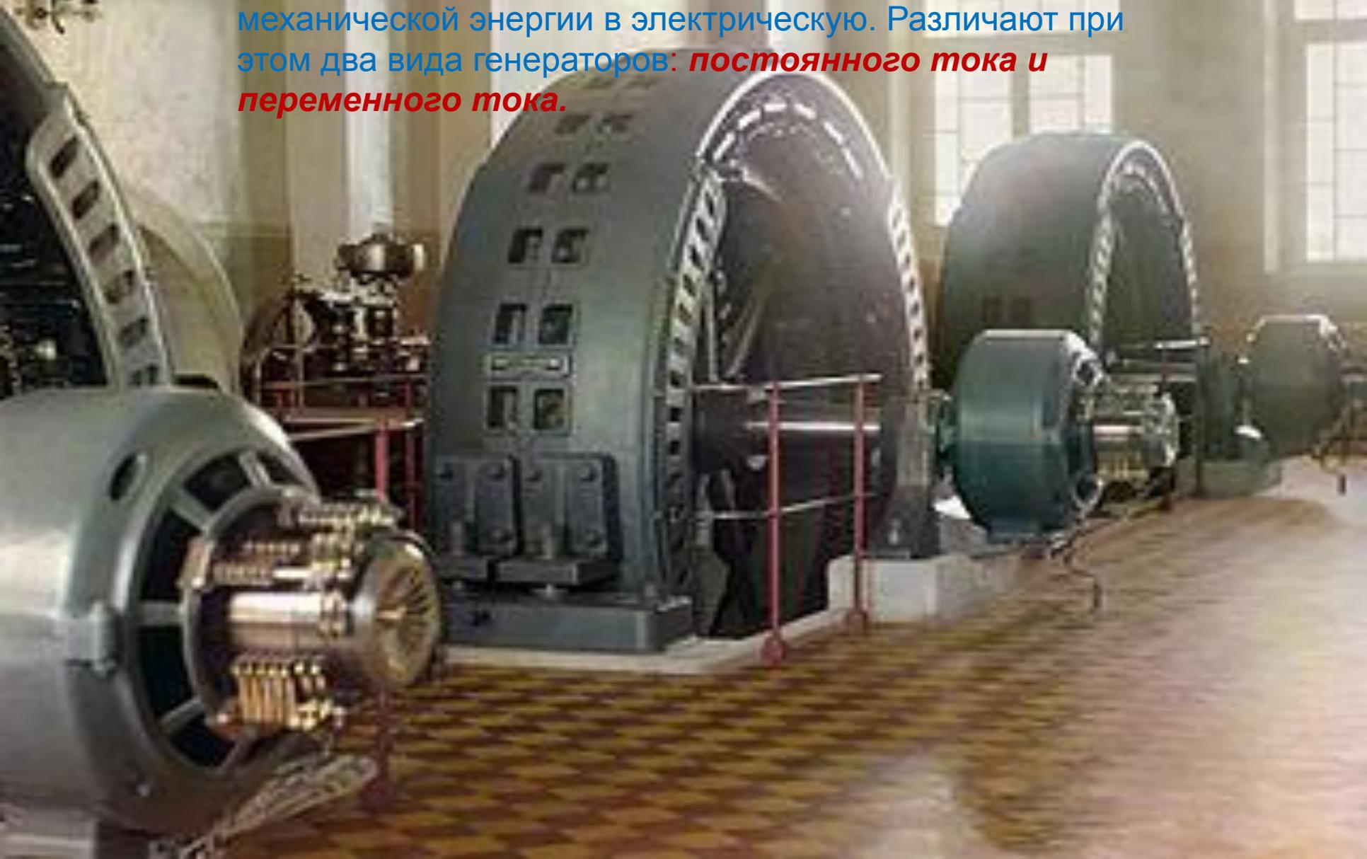
Агрегат, который состоит из статора, якоря, коллекторно-щеточного узла и производит постоянное напряжение, используемое в промышленности и электроэнергетике, называется **генератором постоянного тока**.
