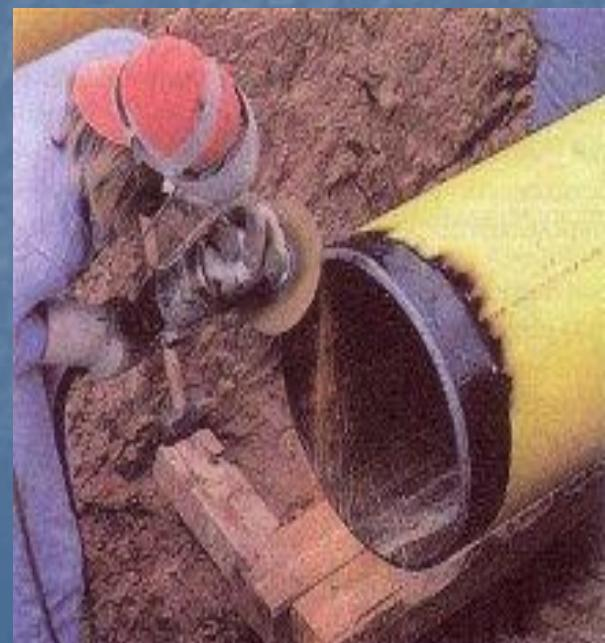
Чтобы избежать проплавления кромок, оставляют притупление в 1,5-2,5 мм.
