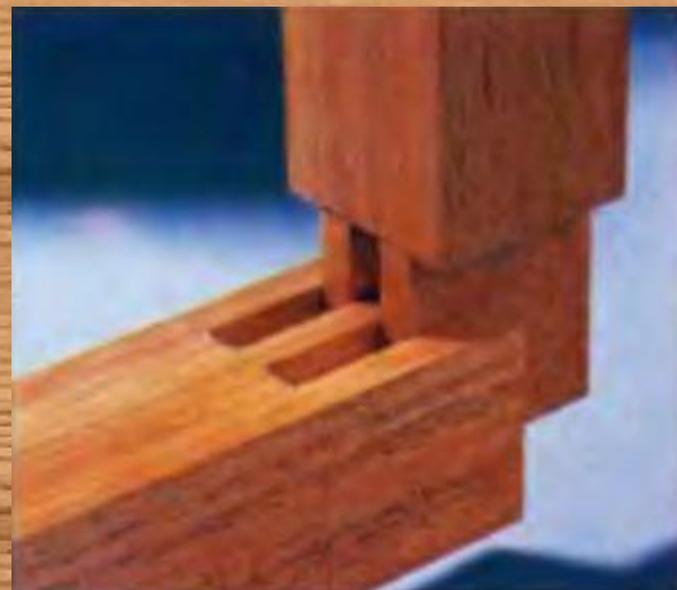
Соединение типа “ласточкин хвост” обладает повышенной прочностью в определённом направлении и, соответственно, применяется по направлению предполагаемых нагрузок. Боковые грани этого шипа наклонены приблизительно на  $10^\circ$ , шип имеет при этом двухсторонний симметричный скос. Чаще всего применяется такая конструкция там, где предполагается усилие на выдёргивание.
