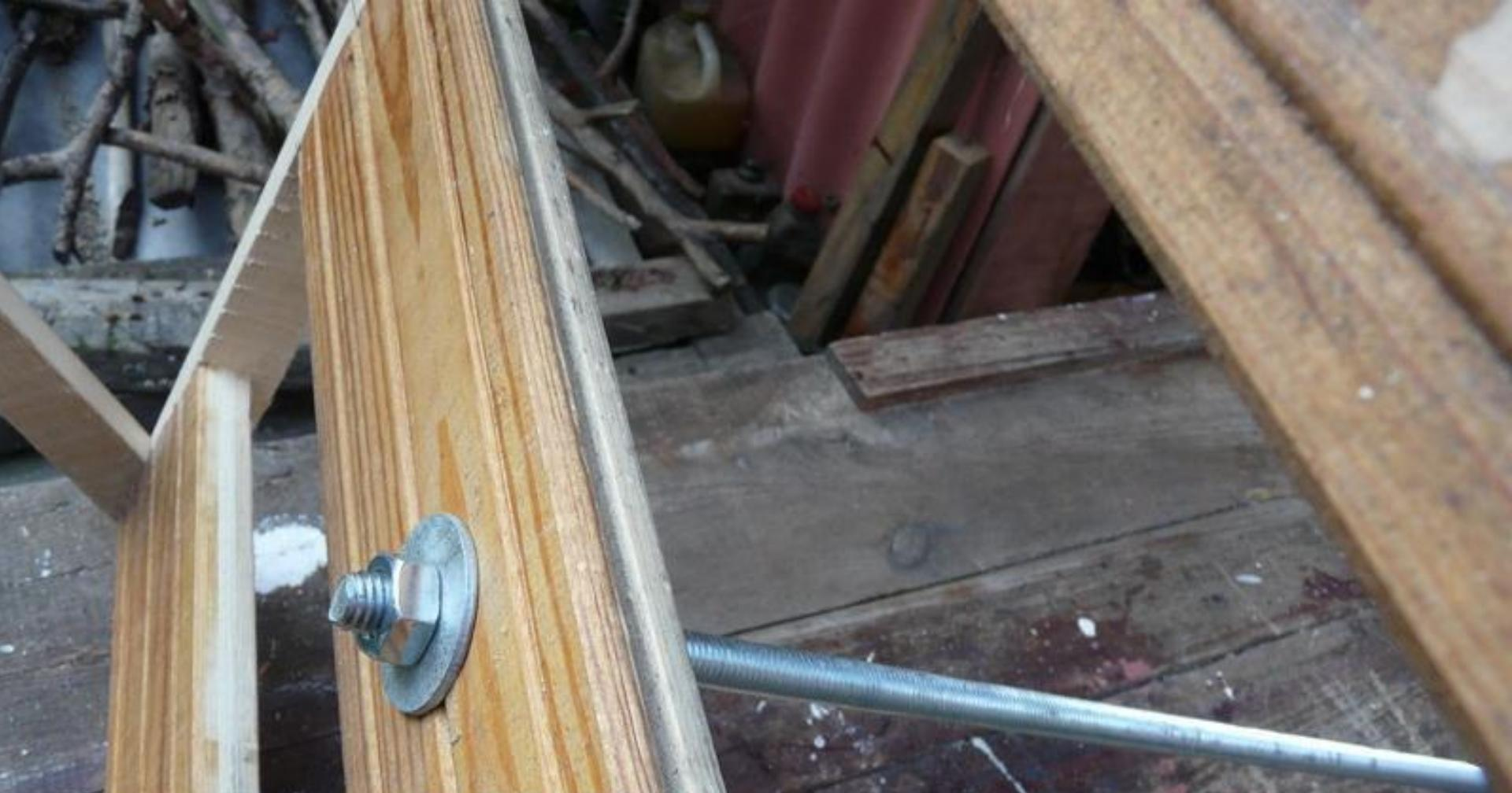
Верхний крепеж вертикальной оси. Итого: гайка с шайбой снизу центральной доски и гайка с шайбой сверху центральной нижней доски крыши. Надеюсь, будет надежное соединение. Горизонтальная ось пройдет над центром вертикальной оси, крепеж - аналогично. Снимки - впереди, работа пока не сделана.
