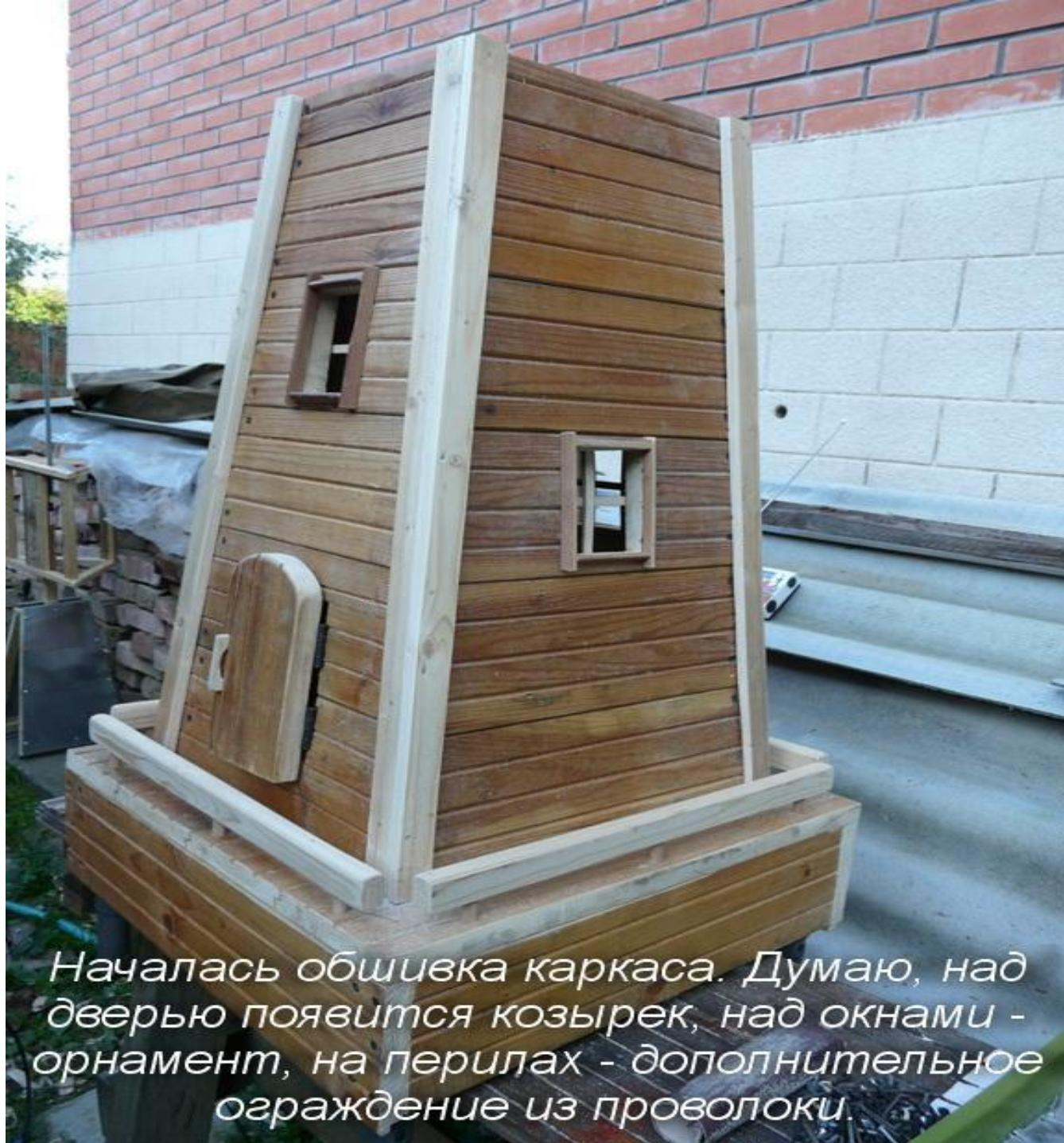
Началась обшивка каркаса. Думаю, над дверью появится козырек, над окнами - орнамент, на перилах - дополнительное ограждение из проволоки.
