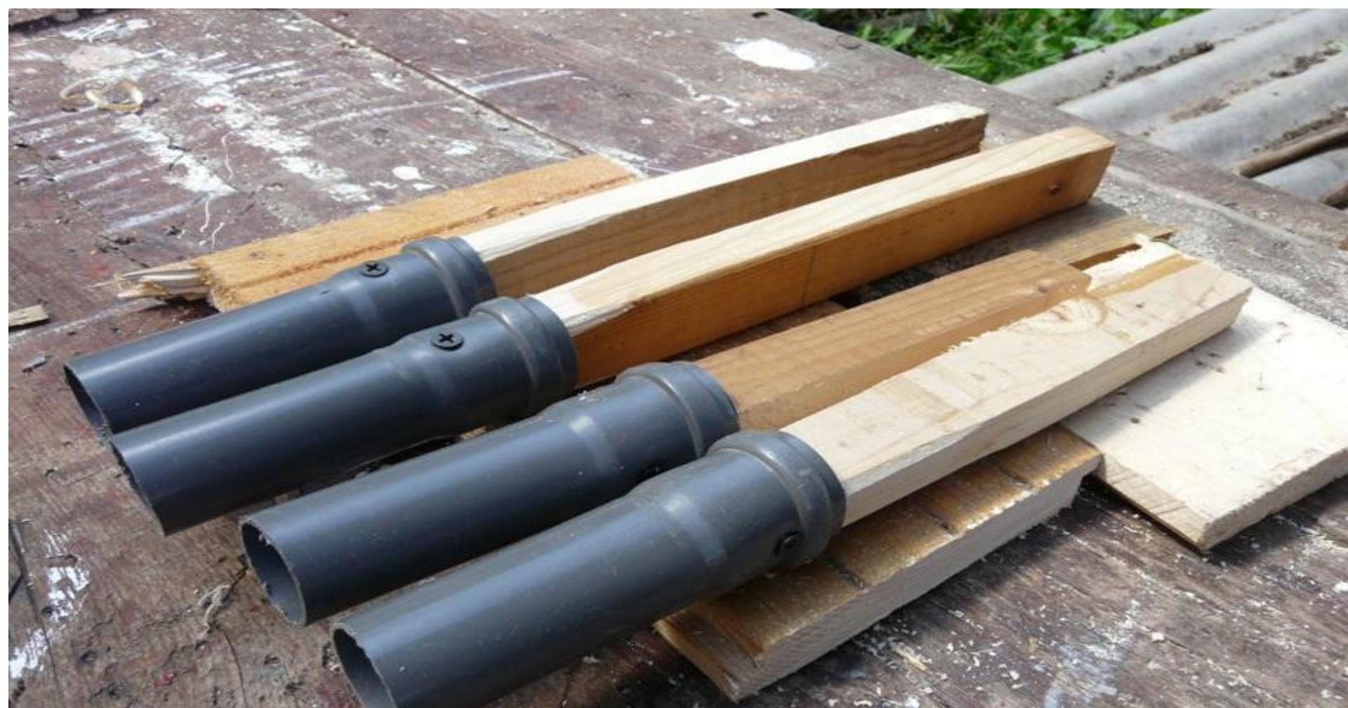
Ножки для будущей мельницы делаем из пластиковых труб, исключая тем самым контакт деревянной части юбки с влажной землей. Кажется, это неплохое решение.
