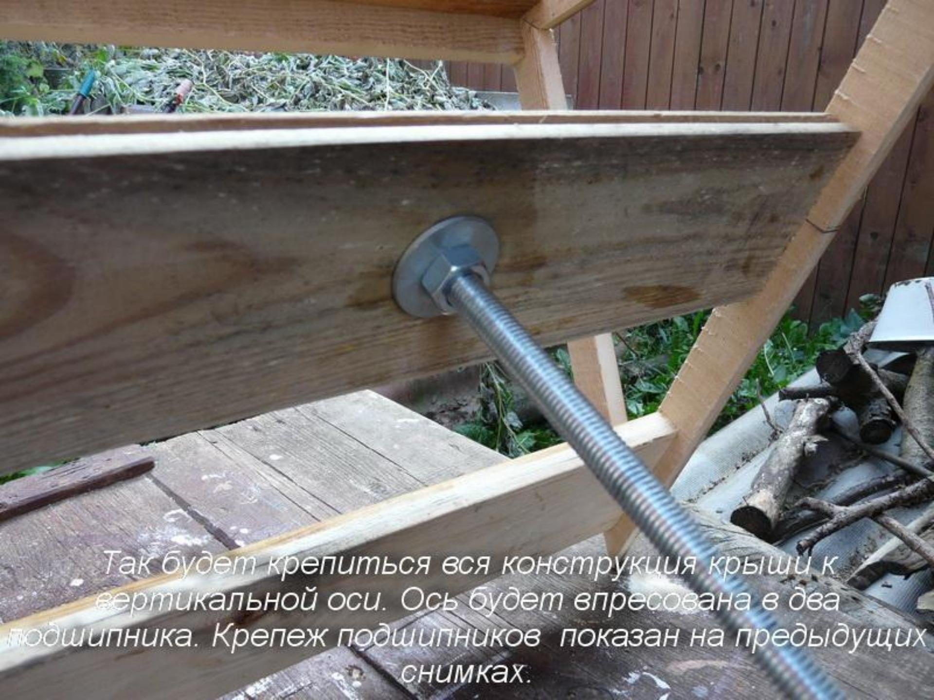
Так будет крепиться вся конструкция крыши к вертикальной оси. Ось будет впрессована в два подшипника. Крепеж подшипников показан на предыдущих снимках.
