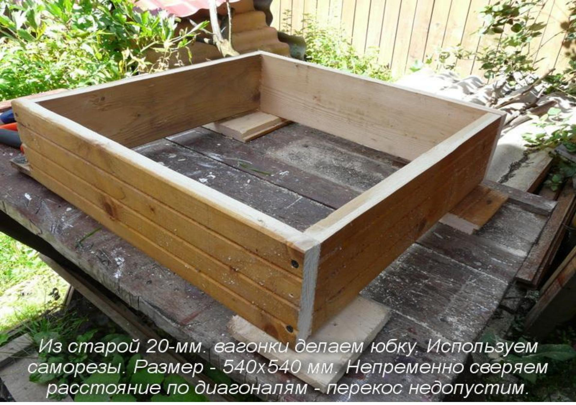
Из старой 20-мм. вагонки делаем юбку. Используем саморезы. Размер - 540x540 мм. Непременно сверяем расстояние по диагоналям - перекос недопустим.
