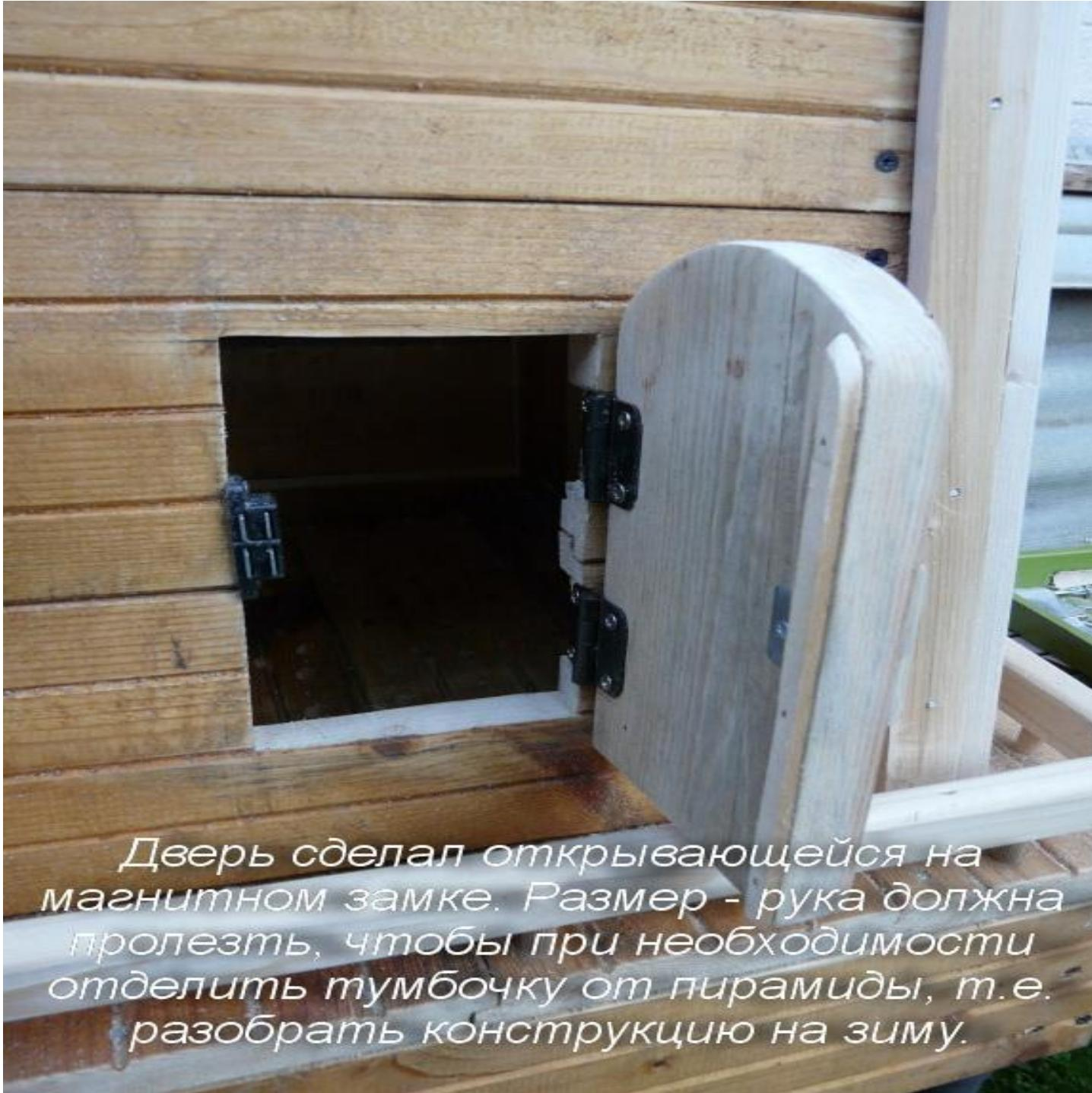
*Дверь сделал открывающейся на магнитном замке. Размер - рука должна пролезть, чтобы при необходимости отделить тумбочку от пирамиды, т.е. разобрать конструкцию на зиму.*
