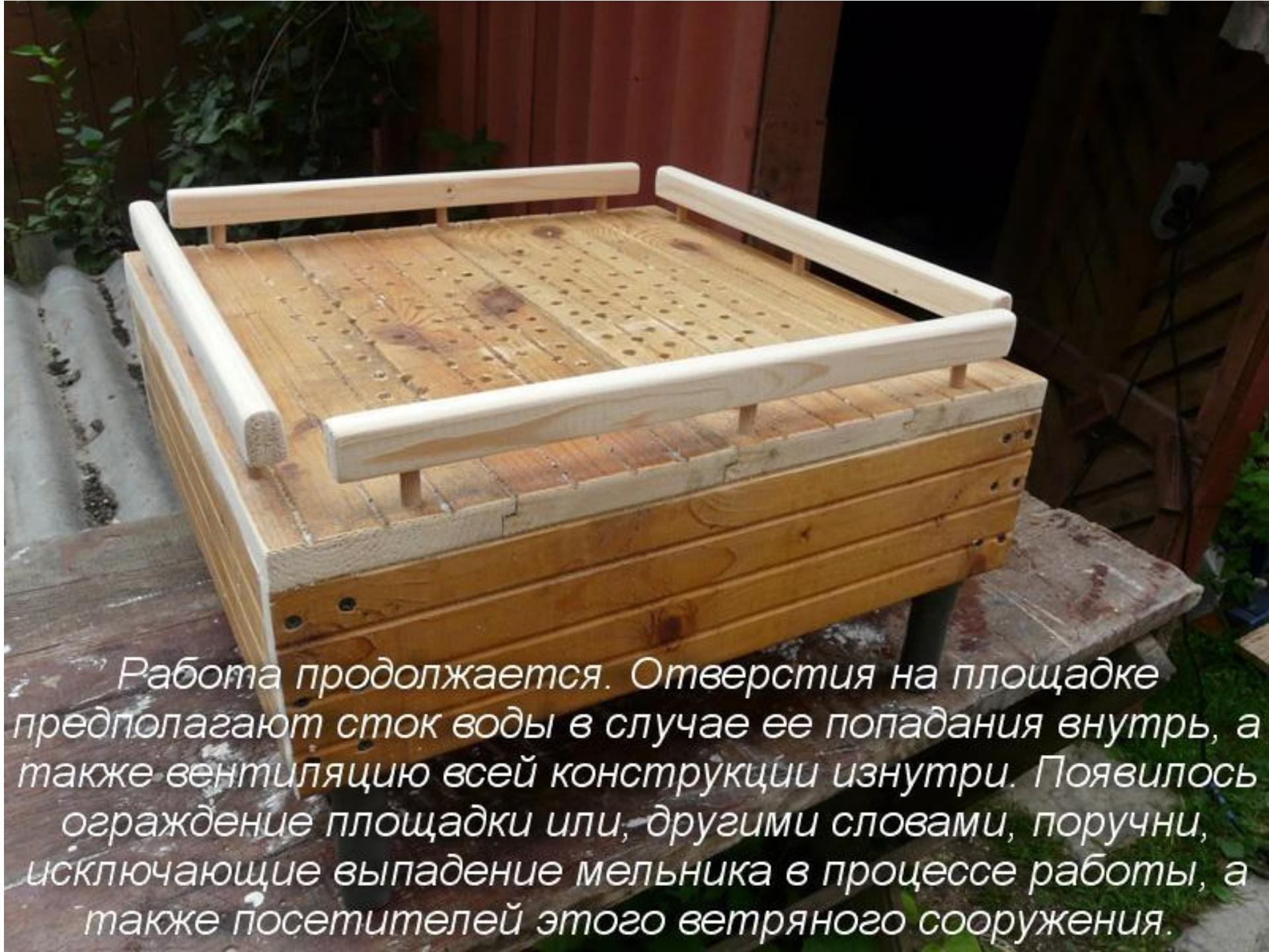
Работа продолжается. Отверстия на площадке предполагают сток воды в случае ее попадания внутрь, а также вентиляцию всей конструкции изнутри. Появилось ограждение площадки или, другими словами, поручни, исключающие выпадение мельника в процессе работы, а также посетителей этого ветряного сооружения.
