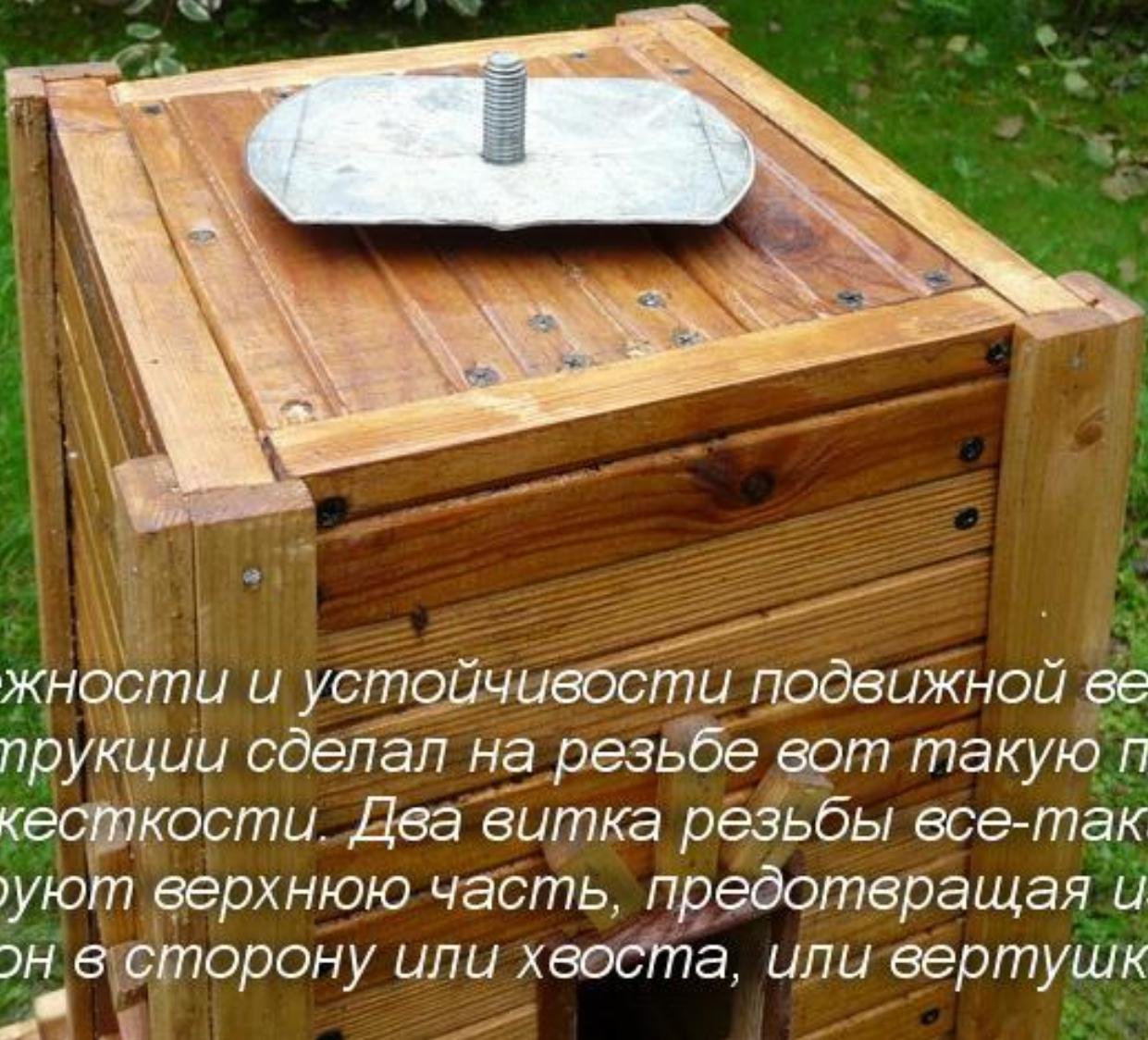
Для надежности и устойчивости подвижной верхней части конструкции сделал на резьбе вот такую площадку с ребрами жесткости. Два витка резьбы все-таки как-то стабилизируют верхнюю часть, предотвращая излишний наклон в сторону или хвоста, или вертушки.
