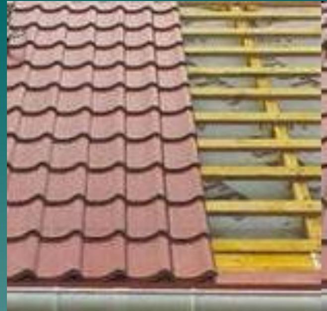
9. Черепица глиняная. Масса кровли – до 65 кг/м<sup>2</sup>.
