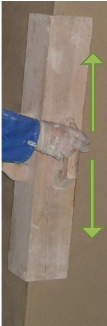
Для натирки усёнков используют такой же раствор как для накрывки. К нанесённому раствору прикладывают полутор и, передвигая его с небольшим нажимом вверх и вниз, до получения точной чистой линии усёнка.
