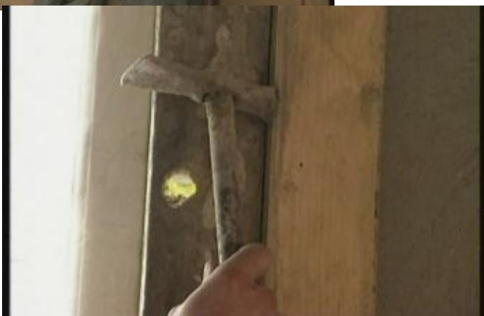
**Рейки крепят к поверхности зажимами, прибивают гвоздями или примораживают раствором. Откосы всегда делают под тупым углом к поверхности стены. Размер угла для верхнего и боковых откосов должен быть одинаковым.**
