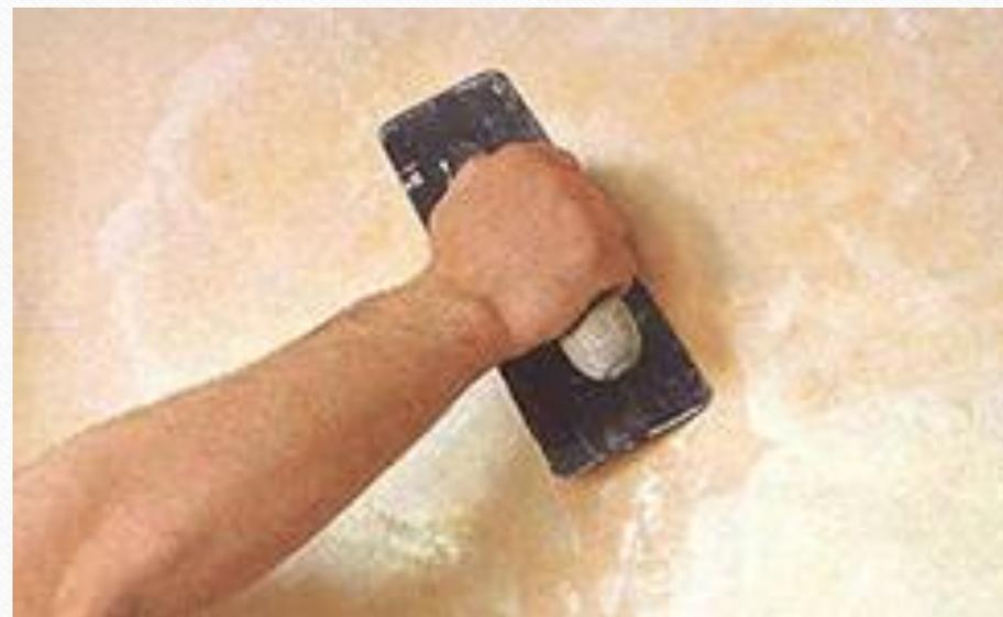
**Второй слой** должен уже проявить нам общую тонировку. Для этого наносим его специальными пересекающимися мазками, которые образуют своего рода пятна на стенах, дают глубину цвета и плавность перехода тонированных линий.
