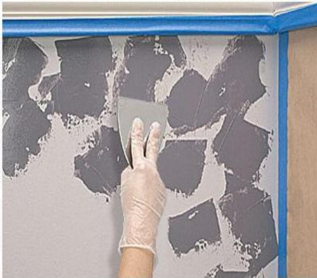
Полировку второго слоя выполняем посредством широкого шпателя, пока штукатурка еще не затвердела.
