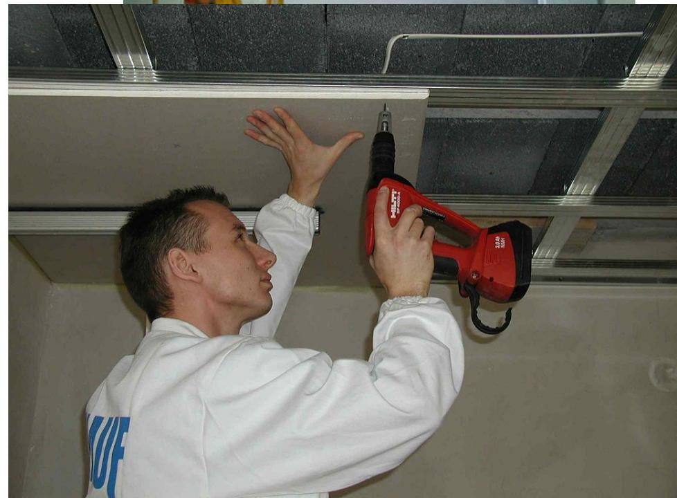
Головки саморезов утапливаются на 1 мм с целью их последующей шпаклёвки.
