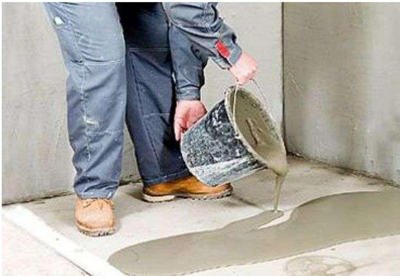
Сначала наносят грунтовку для лучшего сцепления наливного пола с бетонным основанием. После высыхания грунтовки на поверхность выливается приготовленная выравнивающая смесь и разравнивается при помощи шпателя.
