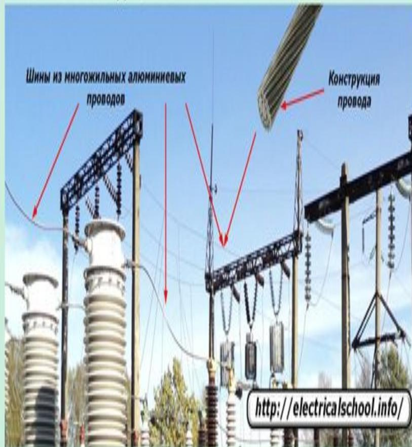
Установка жесткой системы шин на ОРУ-110 кВ
