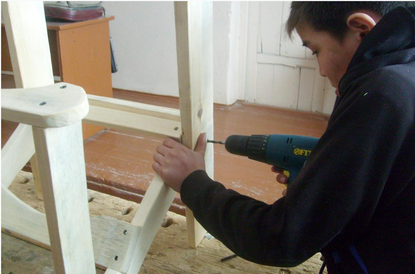
Крепления ножек с помощью болтов.
