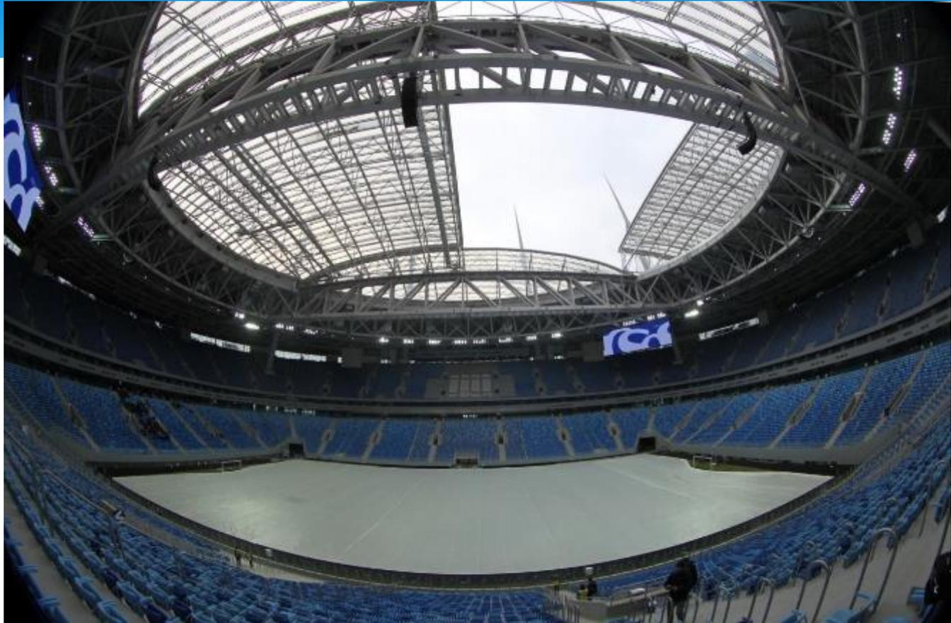
Раздвижная конструкция крыши стадиона схожа с устройством разводных мостов и способна двигаться с нагрузкой до 50 килограмм на квадратный метр, а в закрытом виде она выдерживает до 2 тыс. тонн снега.
