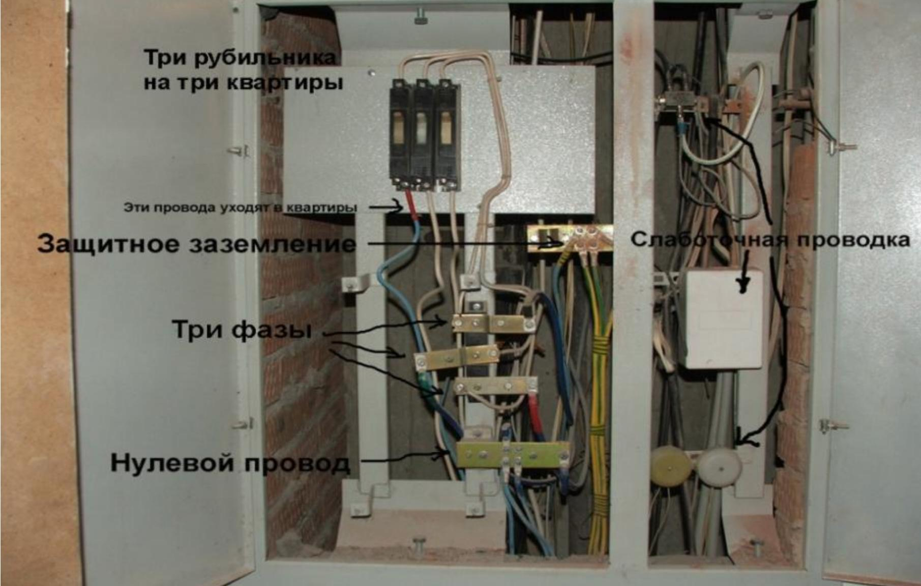
**Ремонт и поиск неисправностей при замыкании
