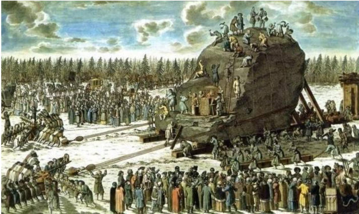
От места нахождения камня до берега залива прорубили просеку. Гром-камень рычагами водрузили на деревянную платформу, опирающуюся на медные шары. Эти шары передвигались по деревянным рельсам, обитым медью. Работы по перевозке скалы продолжались и в мороз, и в жару. Работали сотни людей.
