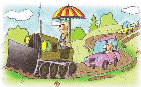
Самая простая дорога – *грунтовая*. Ее строят так: проходит трактор и снимает верхний слой земли вместе с травой. Потом по этой дороге начинают ездить автомобили и укатывают землю, или, как говорят профессионалы, грунт. Или же грунт привозят на самосвалах и делают из него насыпь, а потом укатывают. Сверху на такую дорогу не кладут ни песок, ни камень, ни бетон, ни асфальт.
