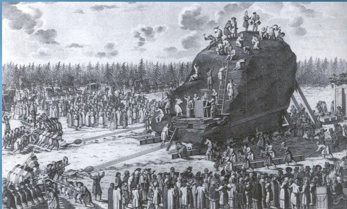
Рычагами эту глыбу водрузили на деревянную платформу на шарах. Эти шары перекатывались по желобам. Так, метр за метром, сотни человек передвигали эту глыбу. Очень тяжелая работа, затем погрузили на баржу и везли уже по реке на барже.
