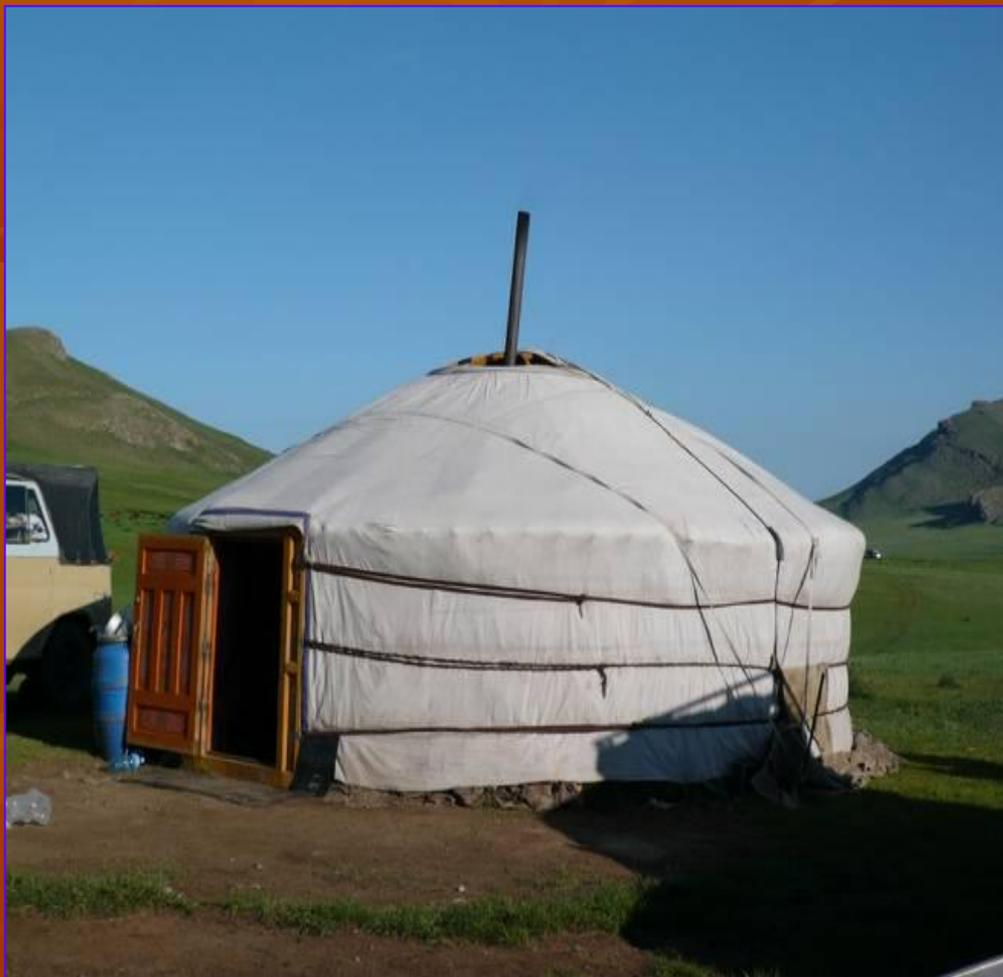
Юрта-деревянный сферический каркас, покрытый толстым войлоком.
