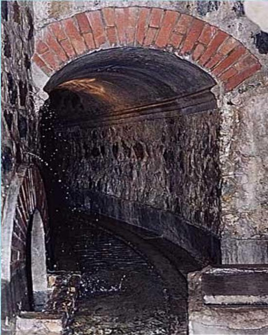
В 1913 году Владимир Николаевич Воейков, владелец села Кувака, с помощью горного инженера Дрейера сооружает каптаж, состоящий из двух подземных штолен, приемной и водоспускной камер и 21 грифона, соединяющихся с разливной камерой двумя водопроводными магистралями.
