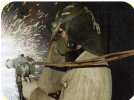
Нанесение алюминиевого ЭМП на стенку нефтяного резервуара
