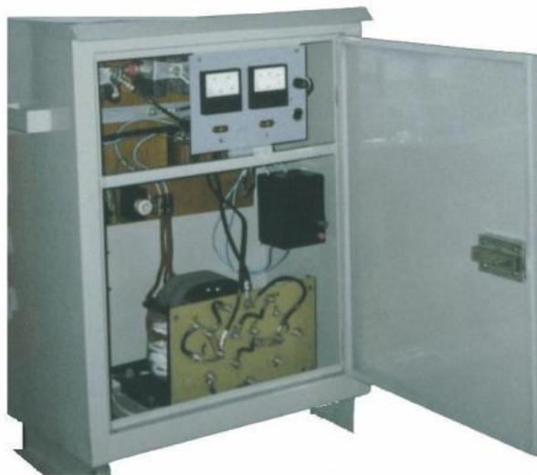
УКЗ-3,0 предназначены для электрохимической защиты подземных сооружений (металлоконструкций, трубопроводов, сосудов) от коррозии
