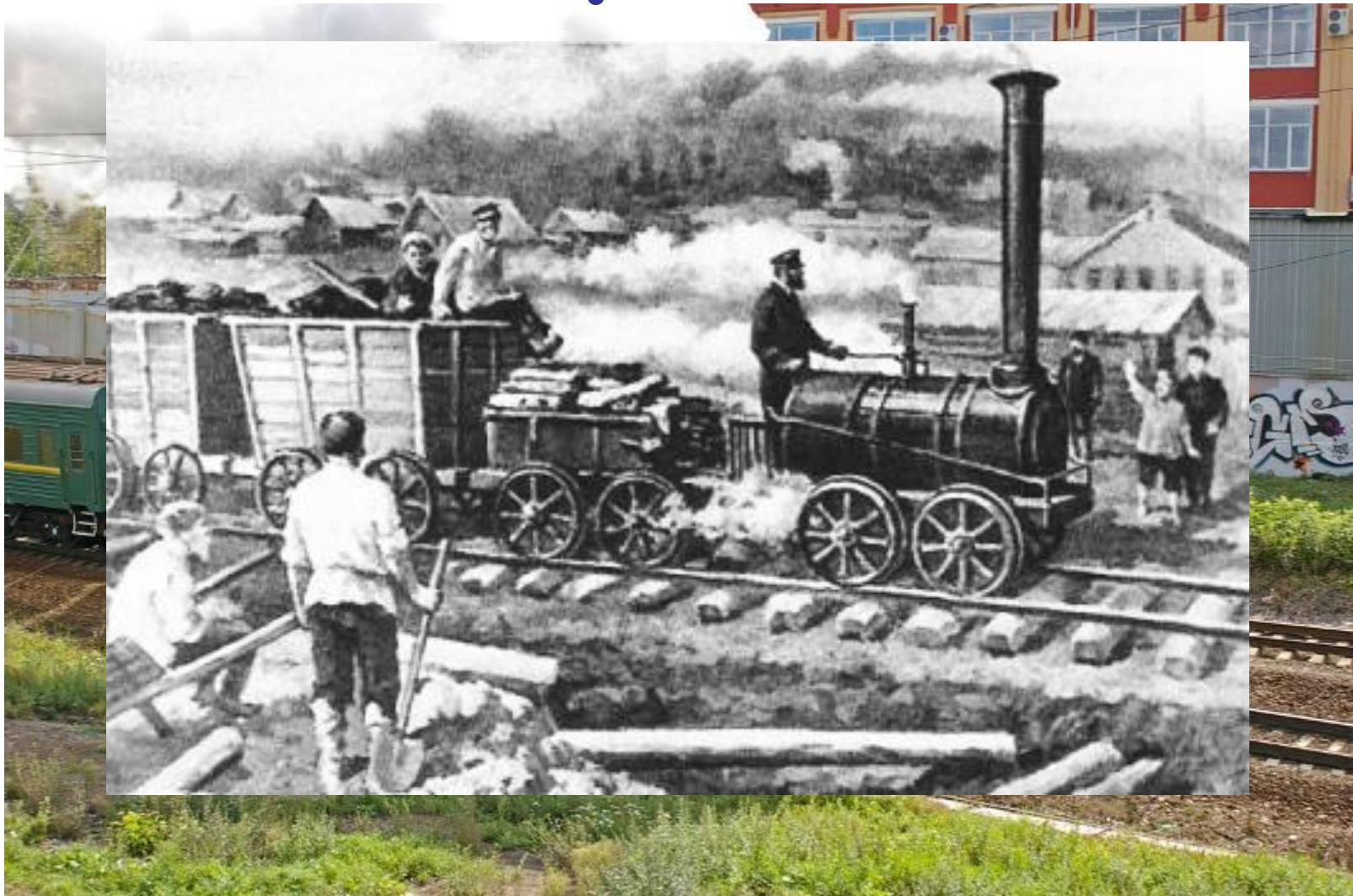
Самыми первыми появились паровозы. Вот какими они были сначала. Этот паровоз ездит на дровах, как печка на колесиках. А вот такими они стали попозже. Здесь уже кочегар кидал в топку уголь, и горячий воздух – пар – приводил в движение двигатель паровоза, а дым уходил в трубу. Смотри, прямо за паровозом – вагон с углем. Вот, сколько его нужно, чтобы паровоз мог ехать сам и тащить за собой тяжелые вагоны.
