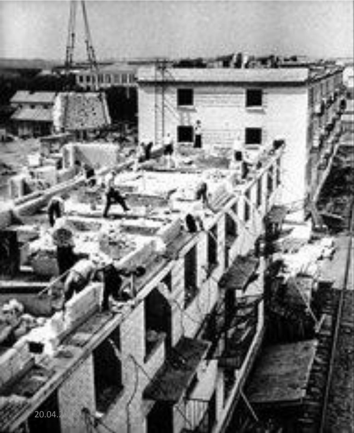
Песок добавляют в раствор цемента, которым на строительстве скрепляют кирпичи.
