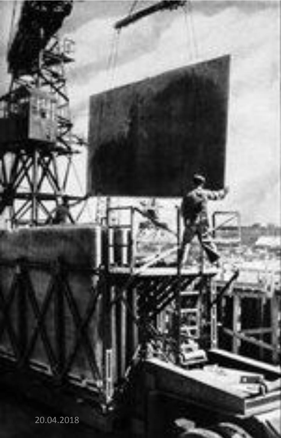
Песок входит и в состав бетона. Из готовых бетонных плит собирают дома.
