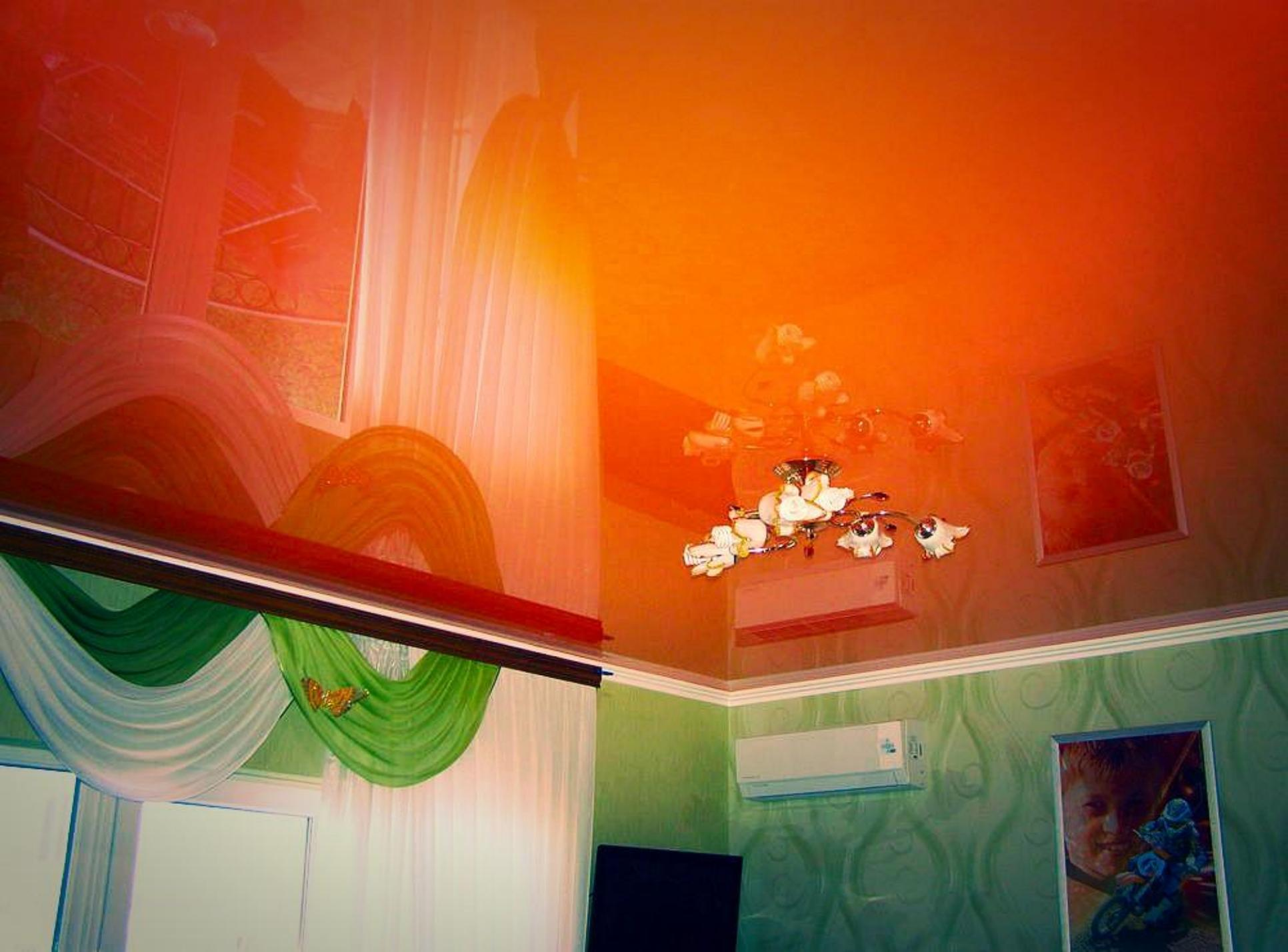
**Потолки из виниловой плёнки** изготавливаются под индивидуальные размеры и конфигурацию помещения. Изготовление происходит на производстве путём сварки полос поливинилхлорида шириной от 1 до 5 метров на ТВЧ-станках. При монтаже полотно натяжного потолка разогревают газовыми пушками до температуры 70 градусов, после чего плёнка размягчается, и её растягивают на предварительно смонтированный профиль. ПВХ потолки поставляются в разных цветах и фактурах (глянец, сатин, мат, замша и т. д.).
