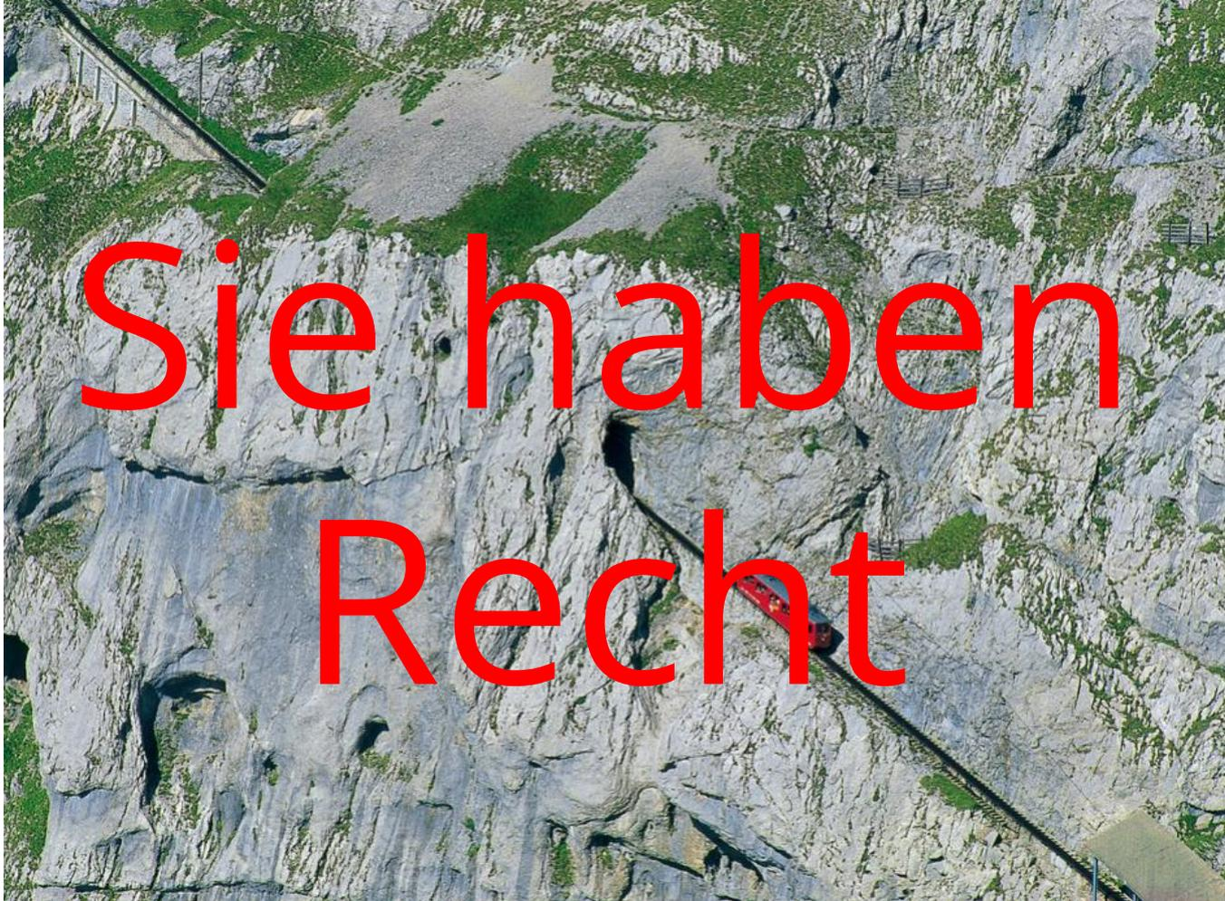
Die **Pilatusbahn** ist nicht nur in der Schweiz, sondern mit einer maximalen Steigung von 48 Prozent weltweit die steilste Zahnradbahn. Auf der 4,6 Kilometer langen Strecke auf den Berg Pilatus überwindet diese eine Höhendifferenz von 1635 Metern
