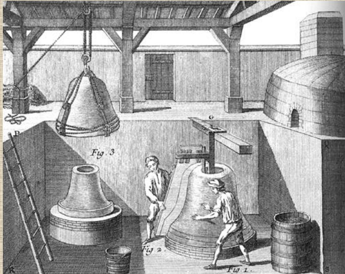
Наилучший материал для изготовления колоколов – бронза, состав которой 4 части меди и 1 часть олова (80% и 20%). Этот сплав слабо рассеивает механическую энергию за период колебания: у бронзы доля рассеяния наименьшая – 0,005. Медь и олово – мягкие материалы, но в сплаве делаются твёрдыми. В сплаве присутствуют примеси: наибольшее количество свинца (~ 2%), цинка (1,2%), железа (1,2%) – вредные примеси.
