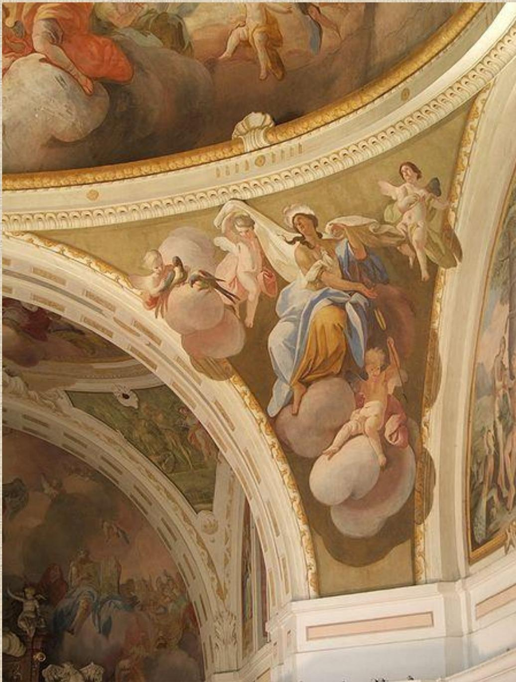
Паруса – элементы купольной конструкции в виде сферических треугольников. С помощью парусов обеспечивается переход от окружности купола или его основания – барабана к прямоугольному в плане подкупольному пространству. Они также принимают на себя распределение нагрузки купола на подкупольные столпы.
