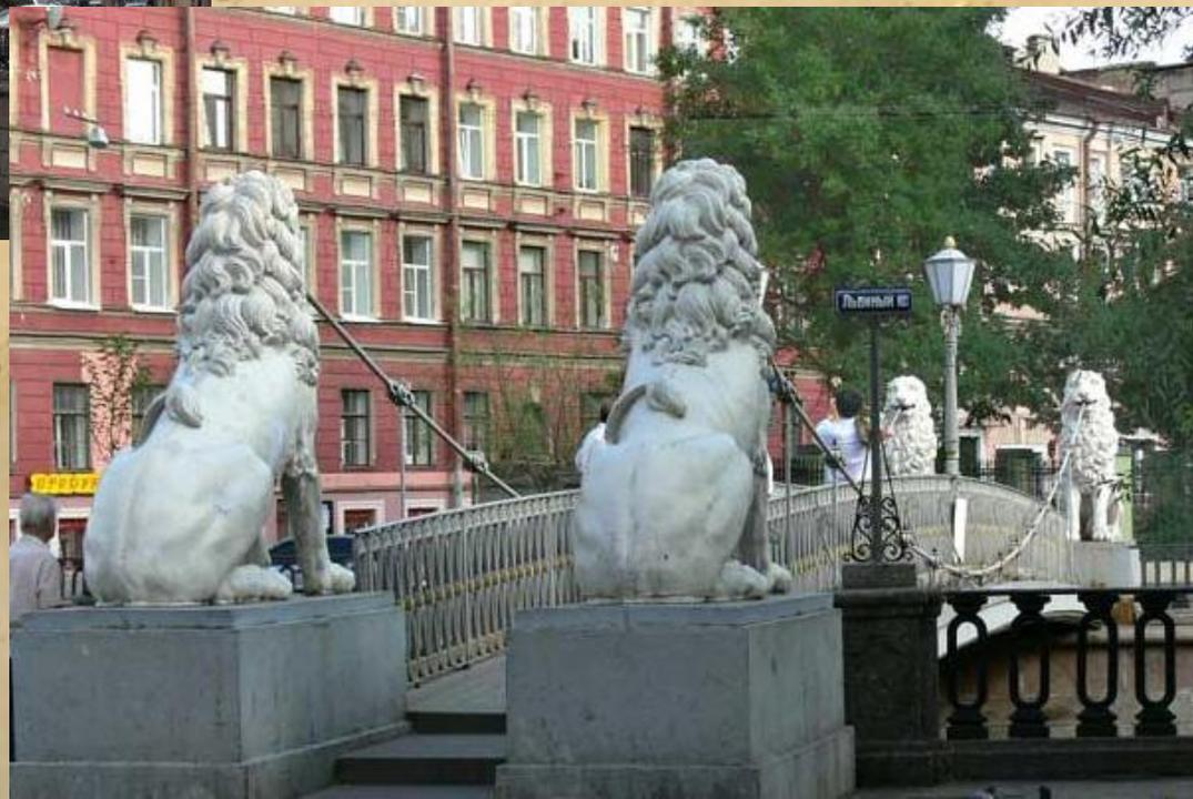
**Львиный мост** стал одним из самых заметных мостов на канале Грибоедова благодаря своему архитектурному оформлению. Цепи висячего моста укреплены в фигурах львов “удерживающих” переправу.
