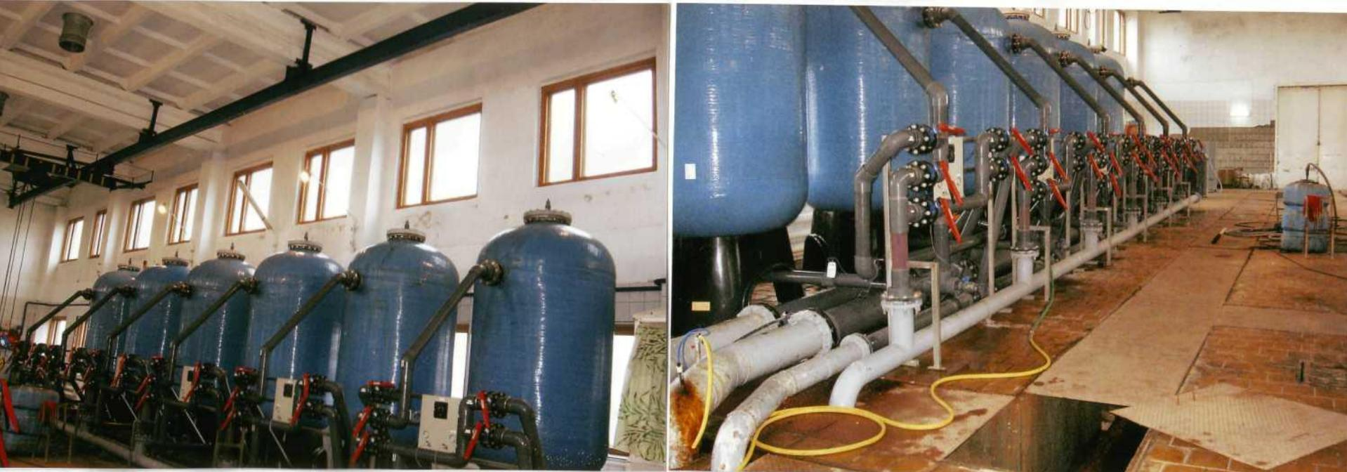
**Очищенная от железа вода собирается во второй накопительной емкости объемом 2000 куб.метров и насосами подается в разводящую сеть. Нерастворимый осадок окислов железа удаляется из фильтров обратной промывкой водой и сбрасывается в отстойники.**
