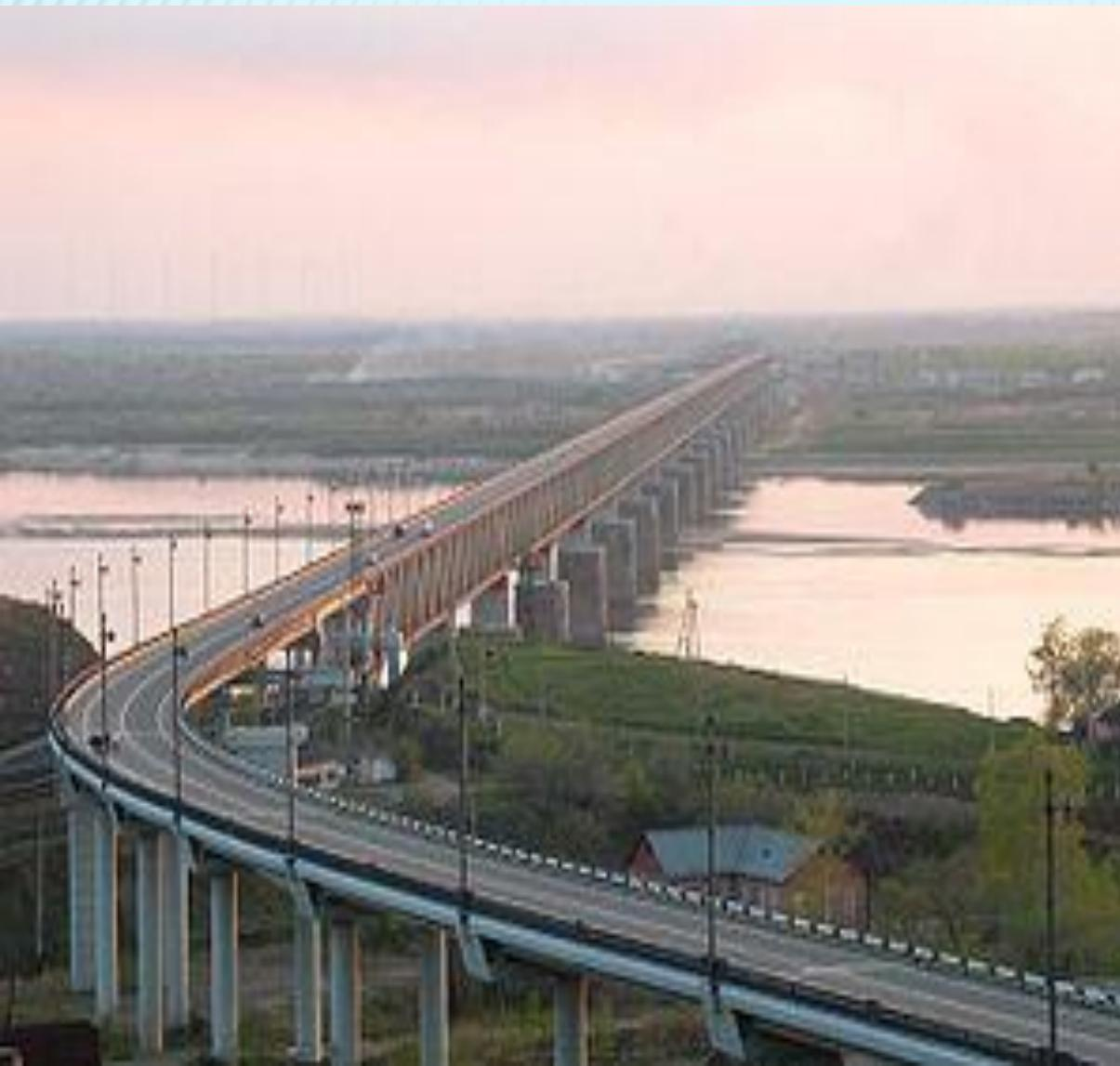
Хабаровский мост или «Амурское чудо», до 1917 года «Алексеевский мост» — совмещённый мостовой переход через реку Амур возле г. Хабаровска с раздельным железнодорожным двухпутным (по нижнему ярусу) и двухполосным автомобильным (по верхнему ярусу) движением.
