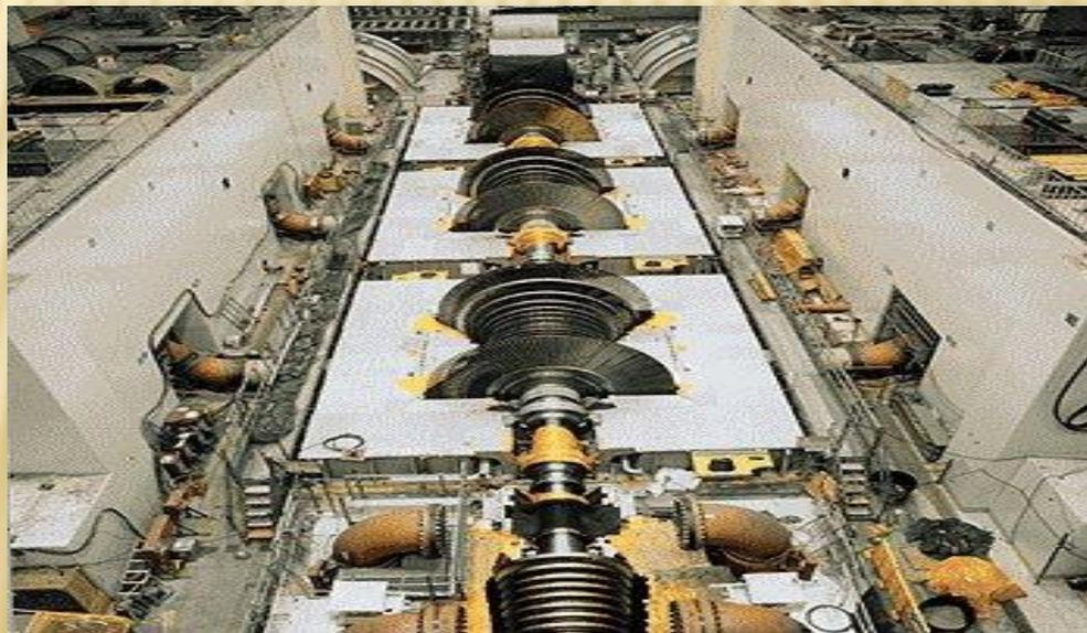
Основные элементы паровой турбины – корпус , сопла и лопатки ротора . Пар от внешнего источника по трубопроводам подводится к турбине . В соплах потенциальная энергия пара преобразуется в кинетическую энергию струи . Вырывающийся из сопел пар направляется на изогнутые рабочие лопатки , расположенные по периферии ротор . Под действием струи пара появляется сила , приводящая ротор во вращение .
