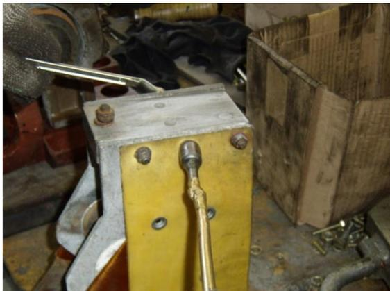
3. гайки крепления перегородок отвернуть, снять шайбы вынуть болты, снять перегородки, затем срубить и выбить заклепки молотком и зубилом
