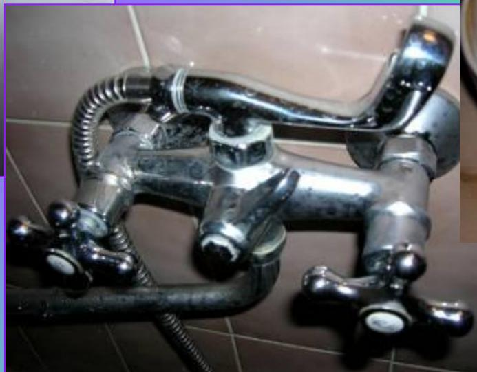
Кран с холодной водой всегда можно отличить по капелькам воды, которые образовались на нём при конденсации водяного пара.
