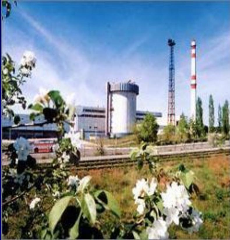
1957г. Вбит первый колышек, закладка барakov, первые жилые дома, ж/д и автомобильная дороги. Первый энергоблок Нововоронежской АЭС проектной мощностью 210 тыс. кВт был пущен в сентябре 1964 года. Это был водоводяной реактор нового корпусного типа тепловой мощностью 760 тыс. кВт. Нововоронежская АЭС стала полигоном для опробования новых корпусных реакторов.
