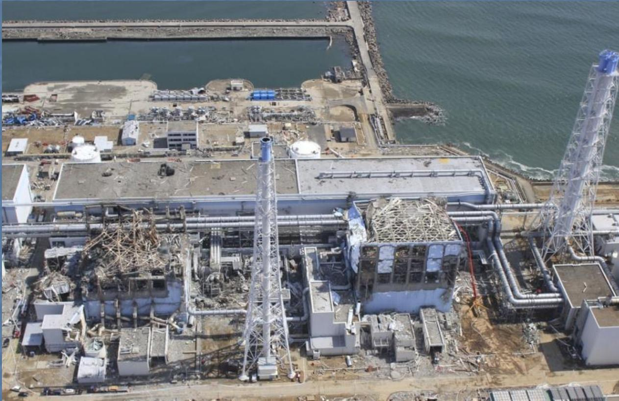
В результате аварии произошло расплавление активной зоны в трех ядерных реакторах. В настоящий момент для охлаждения этих реакторов используется морская вода, которая потом сбрасывается в Тихий океан
