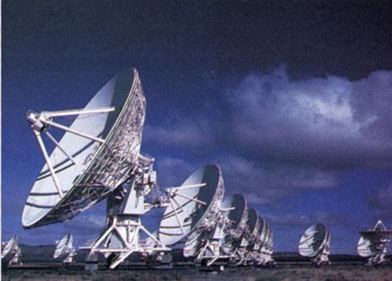
**Система радиотелескопов VLA Very Large Array в Нью-Мексико (США) состоит из 27 тарелок, каждая диаметром 25 метров. Налаживают связь между радиотелескопами, находящимися в разных странах и даже на разных континентах. Такие системы получили название радиоинтерферометров со сверхдлинной базой (РСДБ). Дают максимально возможное угловое разрешение, в несколько тысяч раз лучшее, чем у любого оптического телескопа.**
