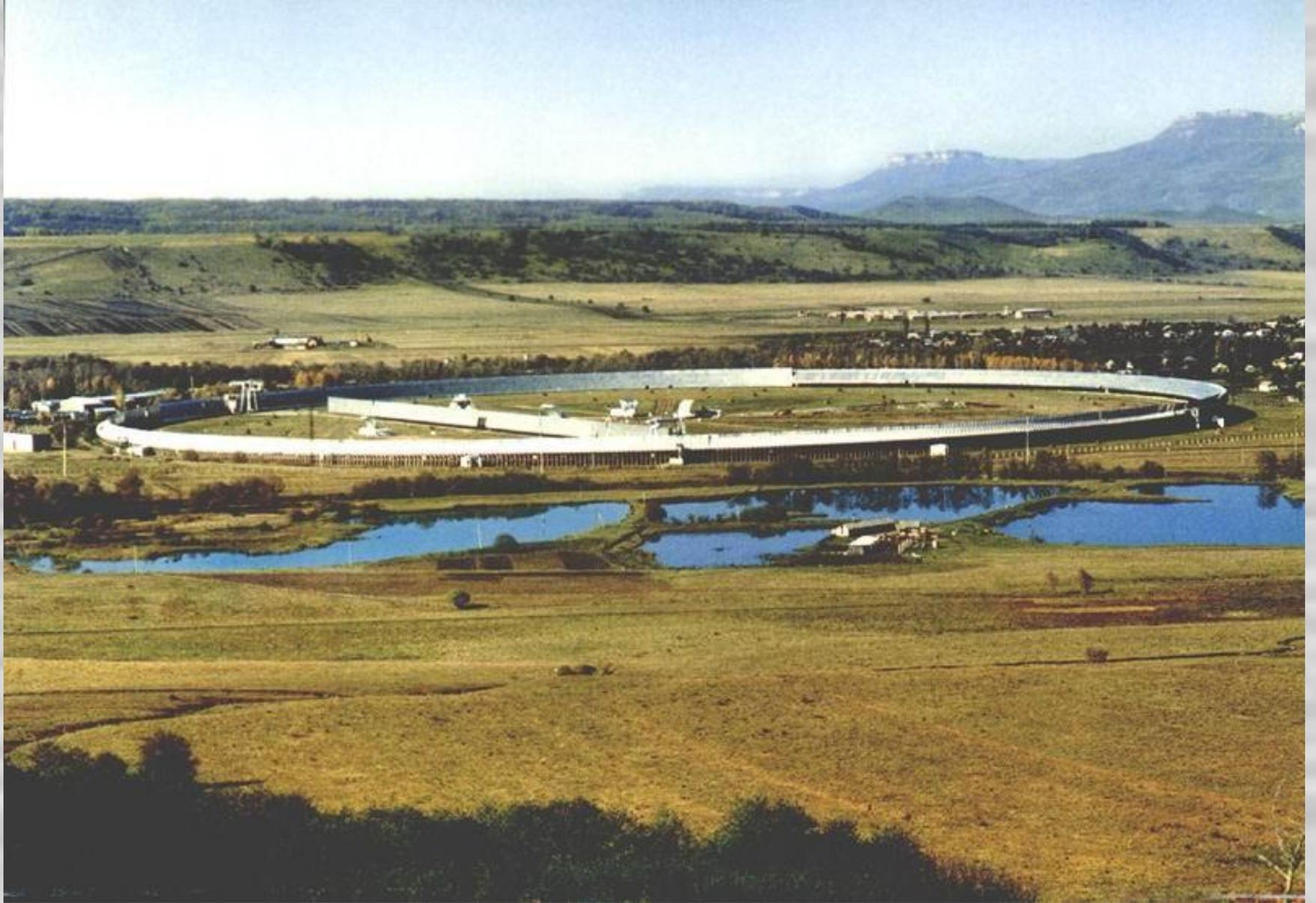
**Радиотелескоп РАТАН- 600, Россия(Сев.Кавказ) , вступил в строй в 1967г , состоит из 895 отдельных зеркал размером 2,1x7,4м и имеет замкнутое кольцо диаметром 588м**
