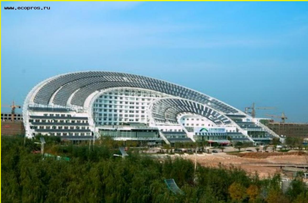
**Эко-стадион на солнечной энергии в Тайване на 100% обеспечивается энергией Солнца. Его перекрытия снабжены 8 844 солнечными батареями общей площадью 14 155 м<sup>2</sup>. Они будут вырабатывать 1,14 млн. кВт·ч в год. Обычно стадион обеспечивает близлежащий жилой район 80% необходимой ему электроэнергии.**
